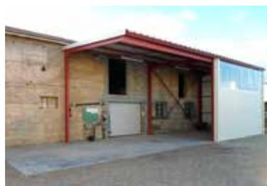
Ne pas avoir à gérer les eaux de pluie implique de couvrir l'aire de remplissage ou de la placer sous un hangar.
