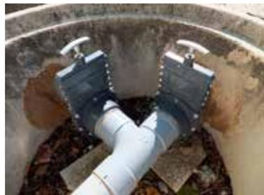
Un exutoire unique sur la dalle, relié à 2 vannes permet de diriger manuellement les eaux souillées vers la cuve de stockage au moment du lavage.
