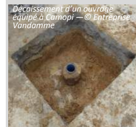
Cimentation ouvrage équipé à Camopi — © Entreprise Vandamme
