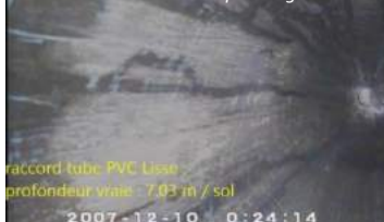
Passage caméra sur un forage AEP de Grand Santi — © Entreprise Ingeneria
